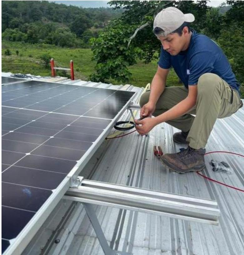
**Figura 7.** Estructura y fijación de los paneles solares
