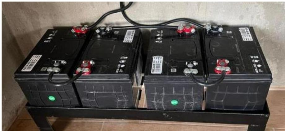
**Figura 5.** Conexión de banco de baterías
