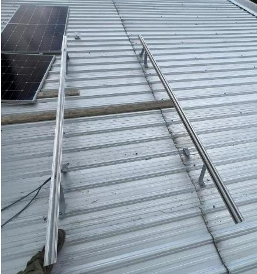
**Figura 9.** Montaje de estructura a 20 cm para ventilación
