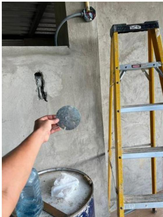
**Nota:** Llego hasta la pared la tubería corrugada luego pusimos una caja de paso para salir con manguera funda sellada de 1/2"
