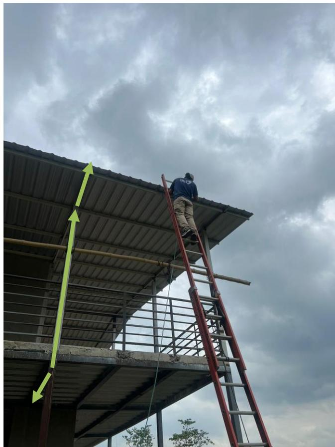
**Nota:** La acometida de los paneles bajan por la estructura de la caja con manguera corrugada de 3/4 y fijada con grapas metálica de 3/4
