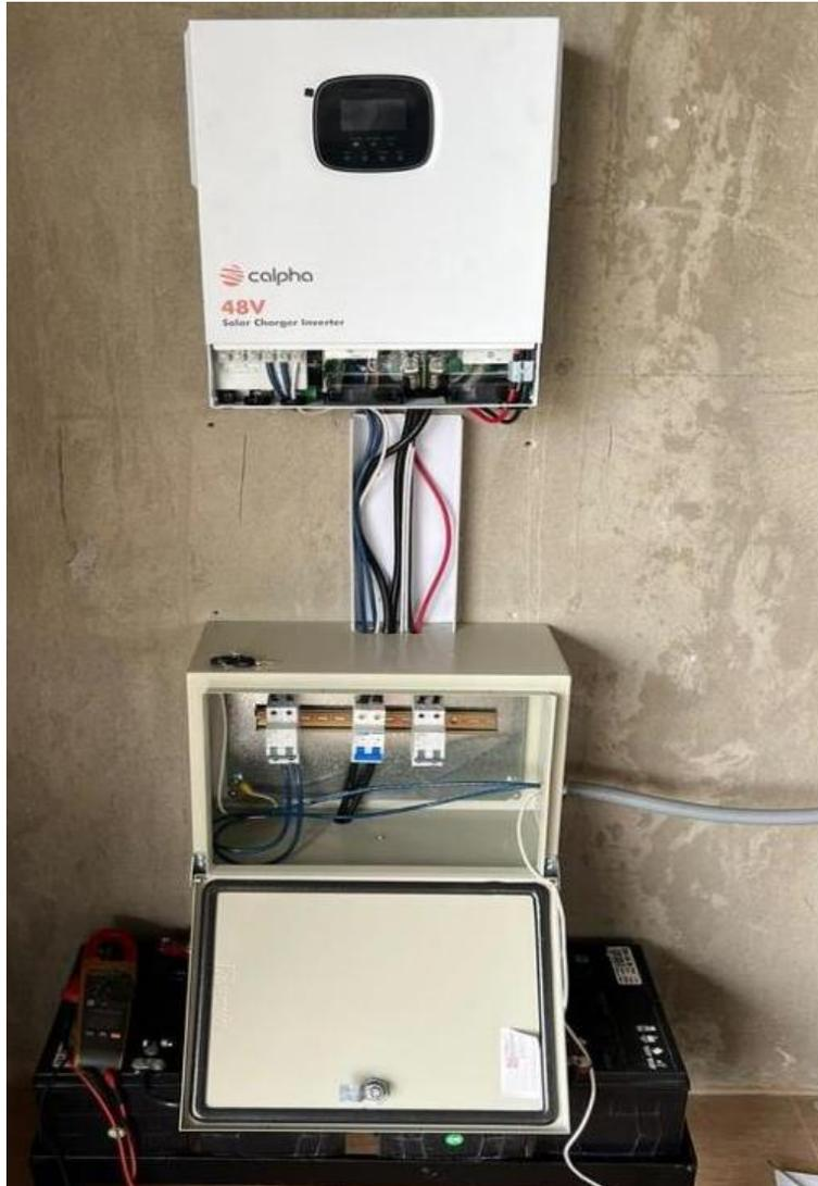
**Figura 8.** Instalación del inversor y la caja de distribución
