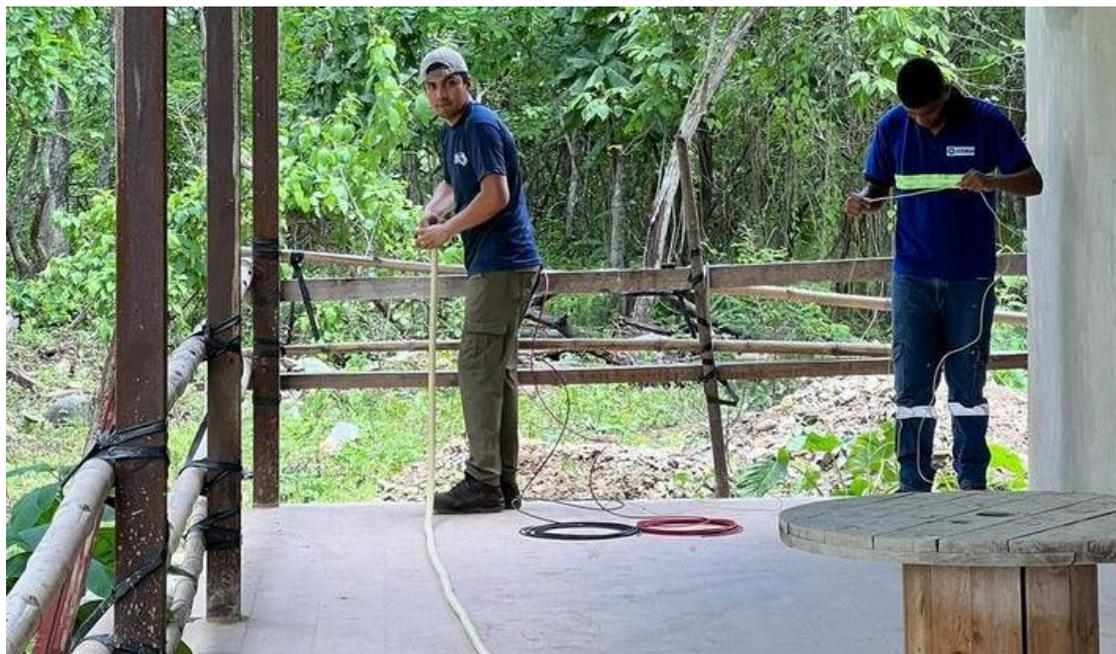
**Figura 10.** Instalación de cable en acometida
