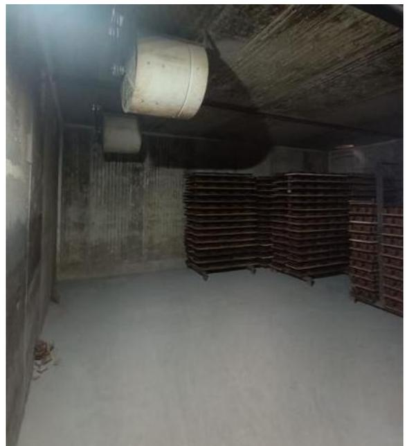
**5.1.2 Sistema de ventilación.** El sistema de ventilación está compuesto por cuatro ventiladores industriales con un diámetro de 70 centímetros cada uno. Estos ventiladores están distribuidos estratégicamente de la siguiente manera:
