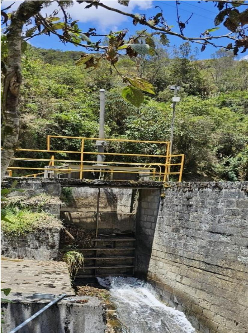
*Figura 5 Compuerta que se realiza estudio para su automatización*
