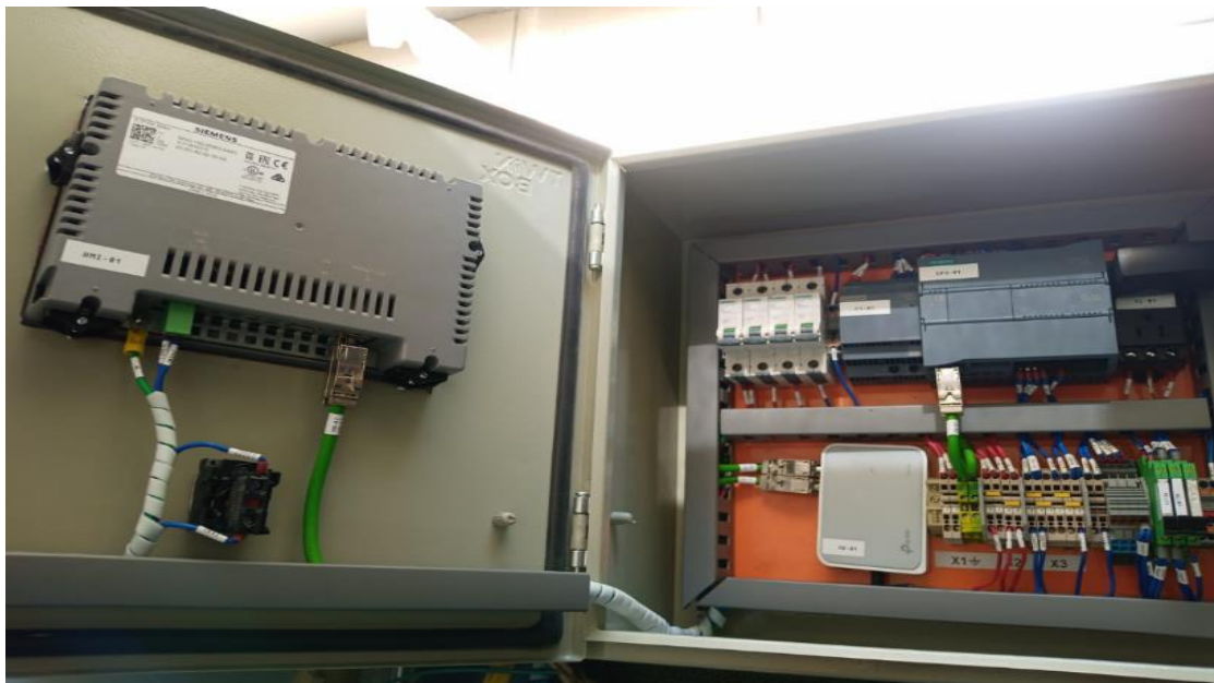
Figura 22: Montaje de Componentes Concluido.
