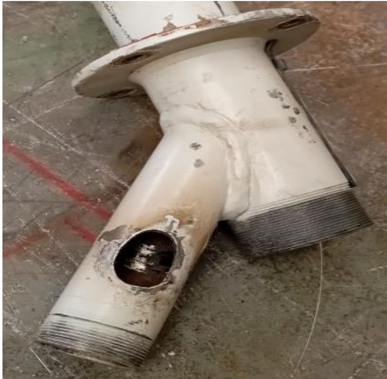
Figura 53: Corte para implementar tubería 1/2" de desfogue
