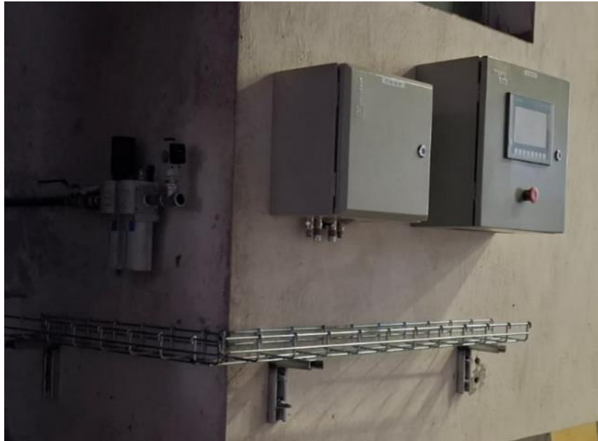
Figura 45: Instalación de tableros y bandeja porta cables.
