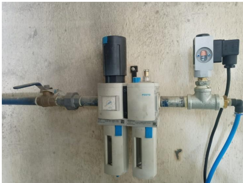
Figura 46: Unidad de mantenimiento y switch de presión.
