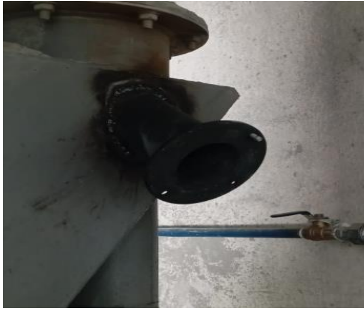
Figura 48: Instalación soporte brida.
