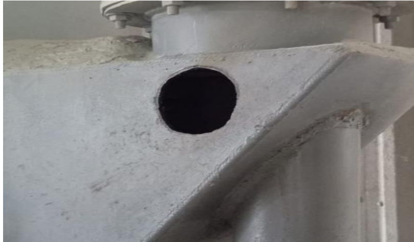
Figura 47: Perforación ducto.
