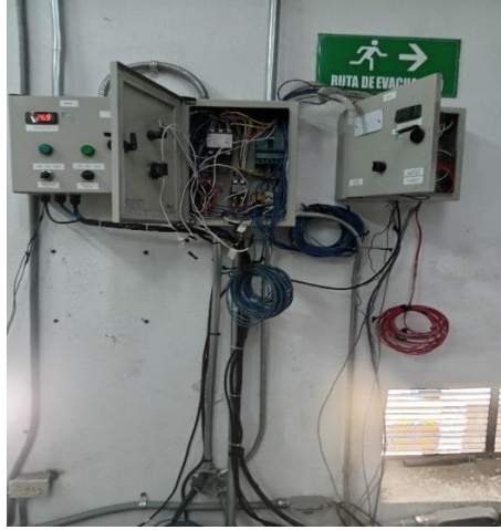
Figura 31 Visualización del retiro del cableado el sistema Antiguo
