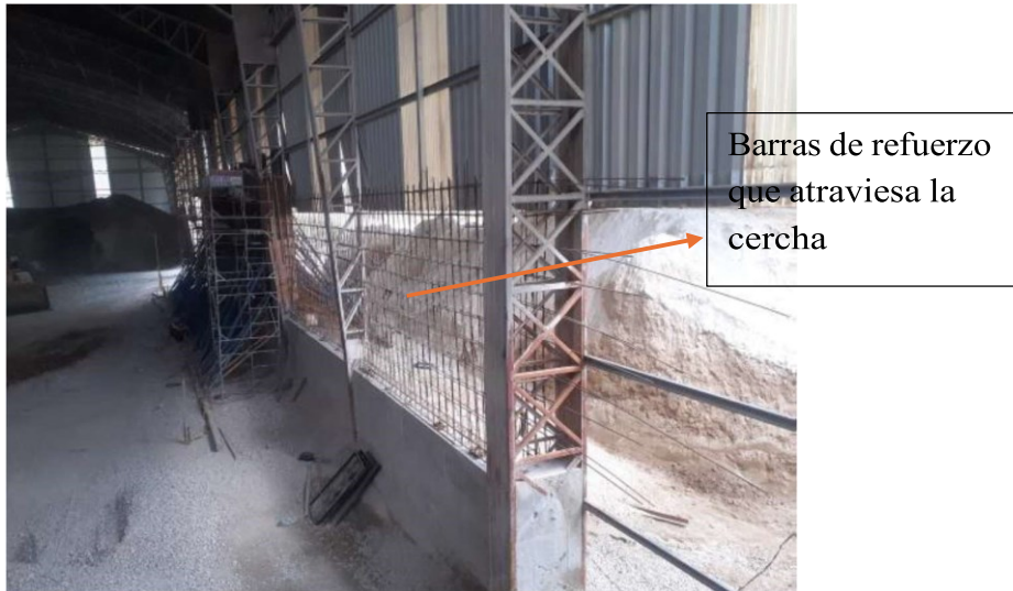
Figura 6 Barras de refuerzo muro de contención
