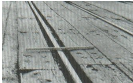
FIGURA 2.19B. CRUCE DE VÍA FÉRREA DE SEVERIDAD MEDIA
