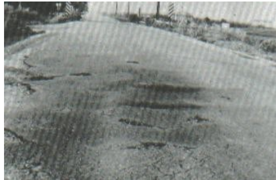
FIGURA 2.21B. DESPLAZAMIENTO DE SEVERIDAD MEDIA
