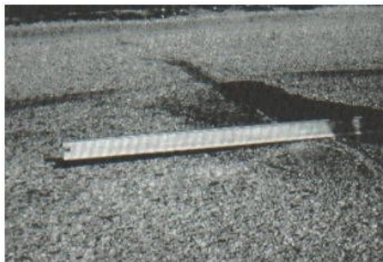
FIGURA 2.9A. ABULTAMIENTO Y HUNDIMIENTOS DE BAJA SEVERIDAD
