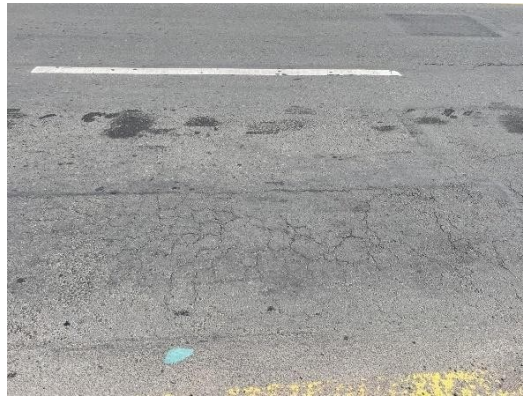
FIGURA 2.6B. PIEL DE COCODRILO DE SEVERIDAD MEDIA
