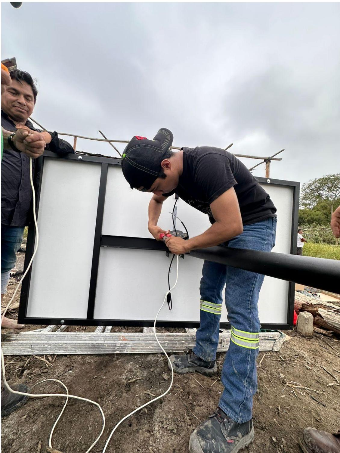
*Unión de panel a base y conexión de cables al sistema.*
