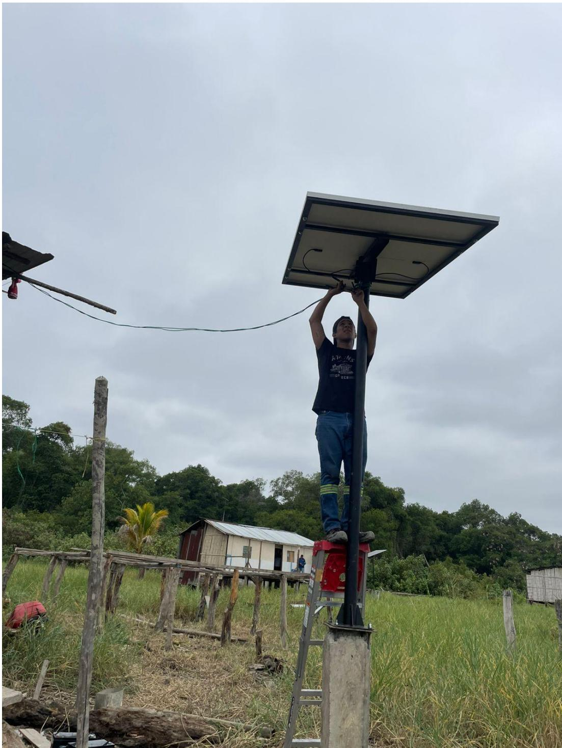
*Conexión del panel a el sistema como: inversor, controlador y baterías.*
