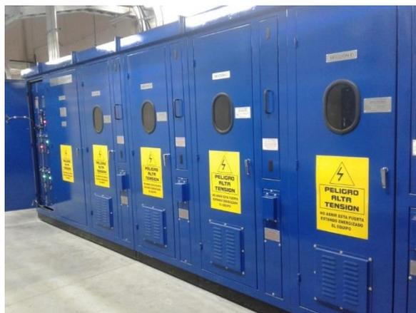
Figura 25: Bancos De Capacitores Con Reactores De Rechazo En Media Y Alta Tensión
