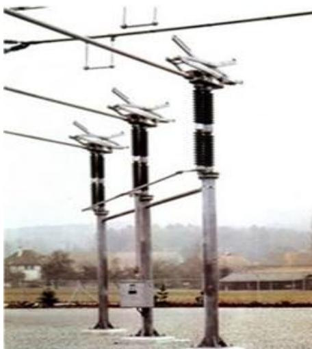
Imagen 12. Seccionador pantógrafo Fuente: SectorElectricidad.com
