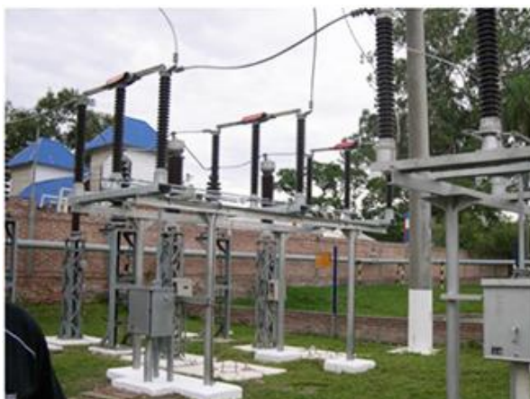
Imagen 10. Seccionador de cuchillas deslizantes Fuente: SectorElectricidad.com
