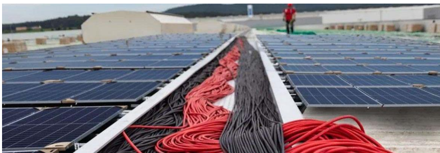
Cableado de paneles solares
