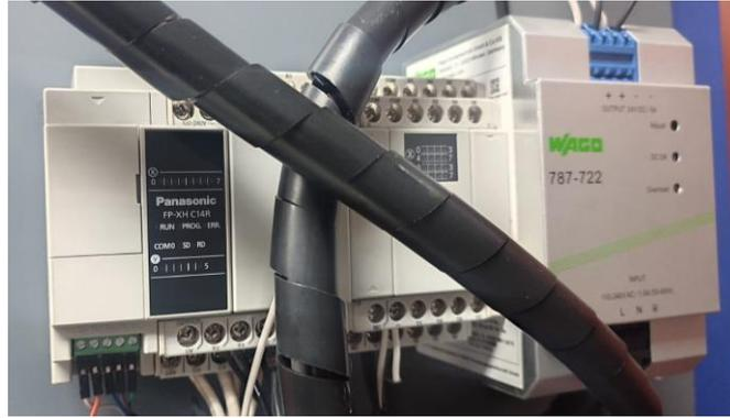
Figura 11. PLC, módulo de expansión y el transformador de voltaje de 110 V a 24 VDC
