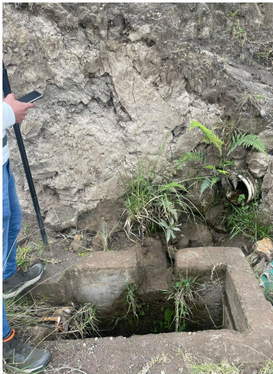
Figura 53 Levantamiento con RTK
