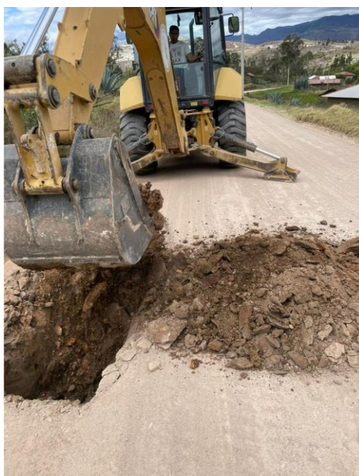
Figura 46 Obtención de calicatas
