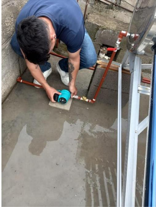
Salida de agua caliente y colocación de bomba de presión de agua
