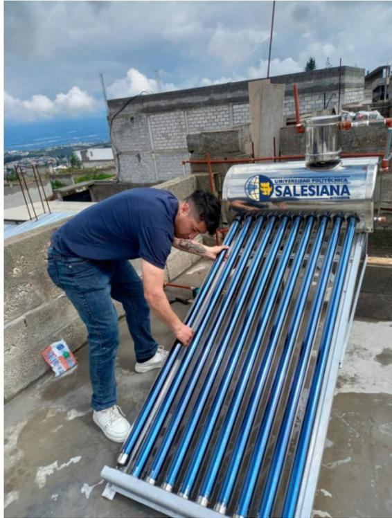
Colocación de termo tanque sobre estructura y de tubos de vacío
