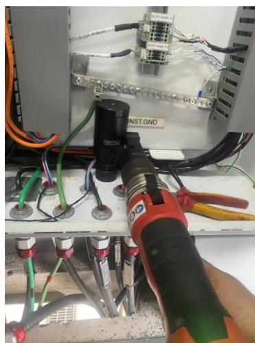
**Figura 118.** Perforación del tablero.
