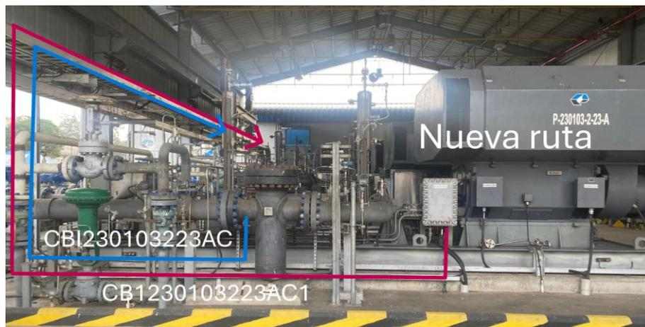
**Figura 122.** Nueva ruta del cable armado.
