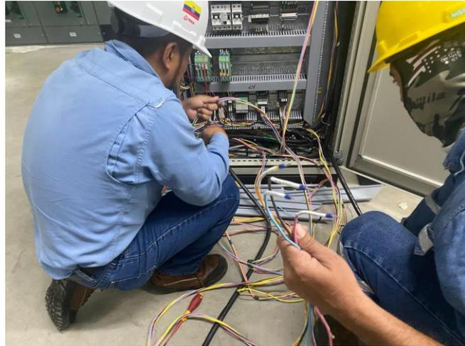
**Figura 117.** Desconexión entradas de instrumentos LOS.
