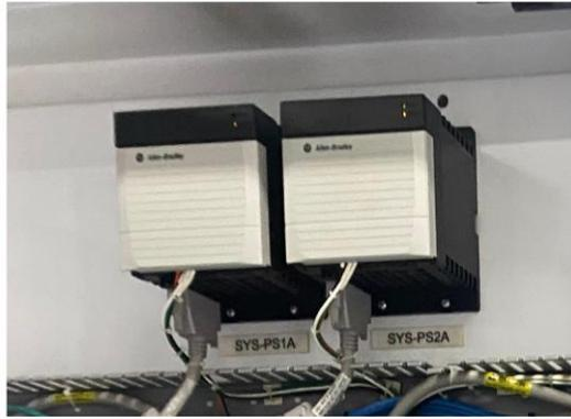
**Figura 36.** Fuente de alimentación redundante.
