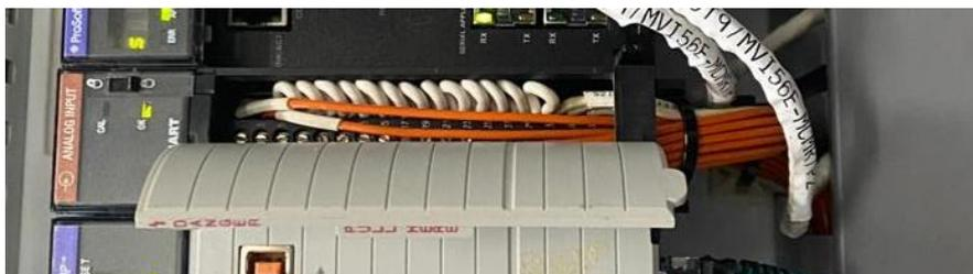
Figura 45. Módulo de entradas analógicas.
