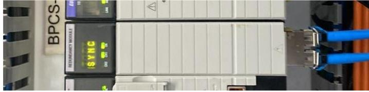
**Figura 39.** Módulo de comunicación redundante.
