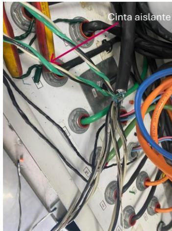
**Figura 121.** Recubrimiento de tierra.
