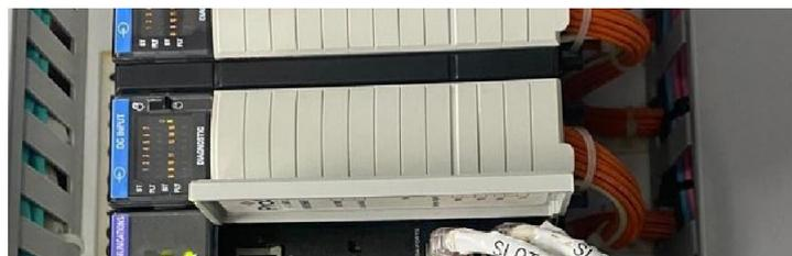
**Figura 47.** Módulo 1756-IB16D
