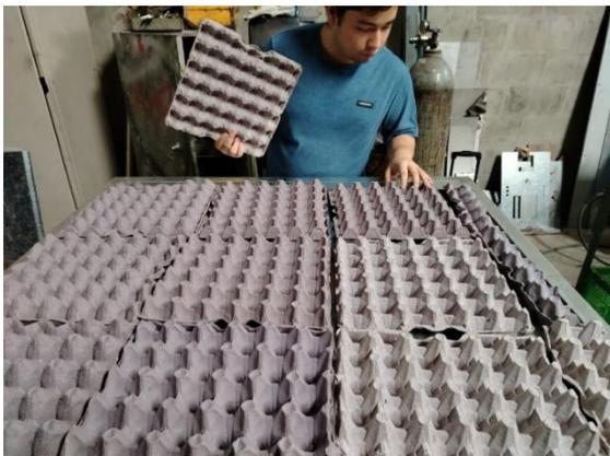
**Ilustración 69:** Cubetas de celulosa, sobre la estructura de la cabina
