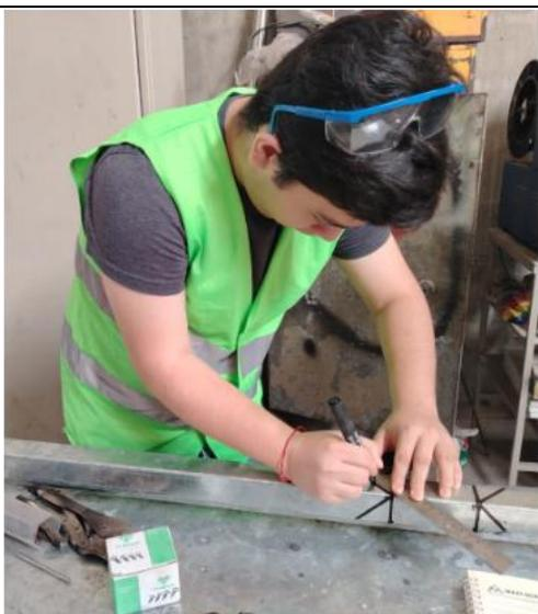
**Ilustración 55:** Trazado de forma en perfil
