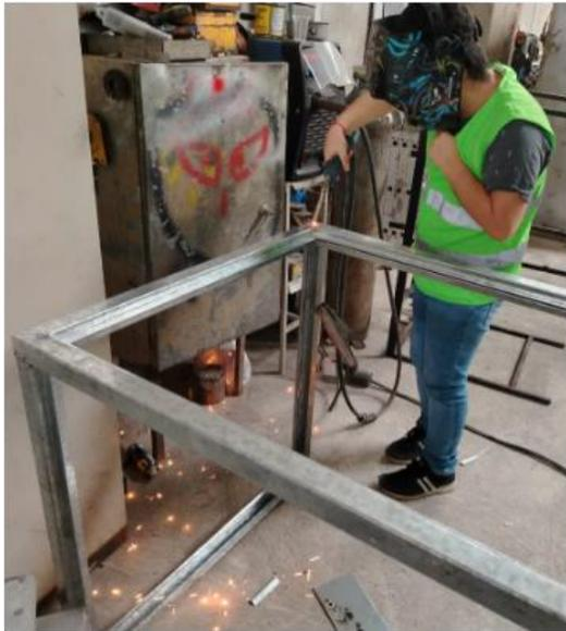
**Ilustración 57:**Proceso de soldado de esquina posterior izquierda de estructura metálica de cabina
