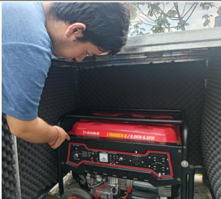
**Ilustración 81:** Generador FFR, listo dentro de cabina
