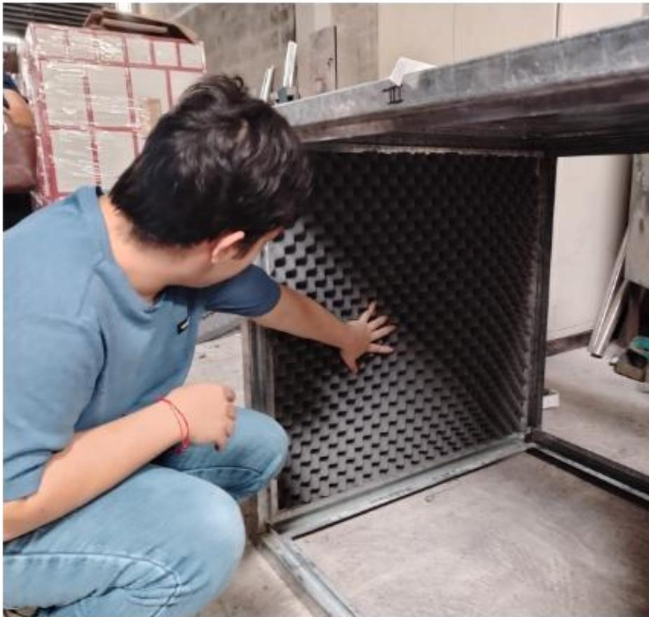
**Ilustración 80:** Instalación de panel acústico de esponja piramidal en panel lateral izquierdo de cabina
