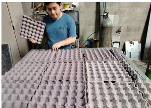
**Ilustración 71:** Colocación de cubetas de celulosa, sobre panel superior
