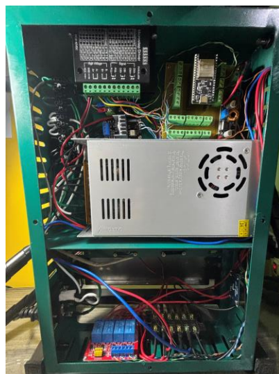
Figura 41. Montaje eléctrico de la máquina.
