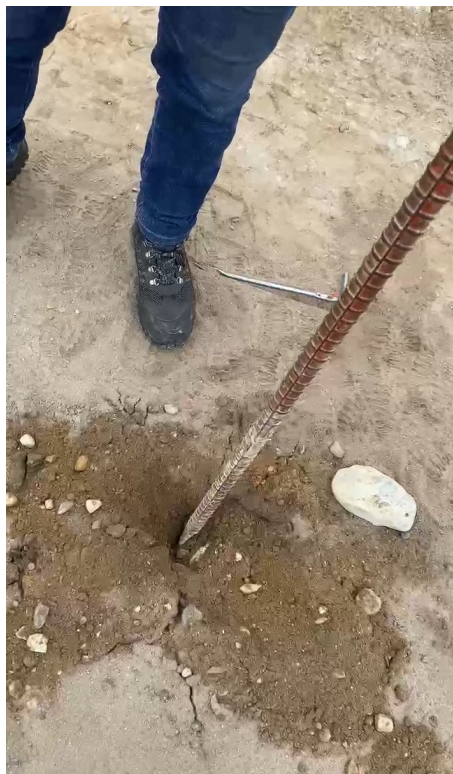
Figura 5.5: Removiendo la tierra para enterrar las picas. Fuente: Autores.
