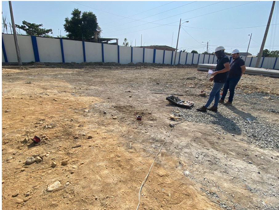
Figura 5.6: Medición de la Resistencia del Suelo.
