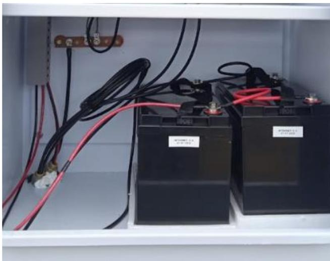
*Nota.* Fotografía capturada por el autor de baterías y sus conexiones empleadas para un sistema fotovoltaico.
