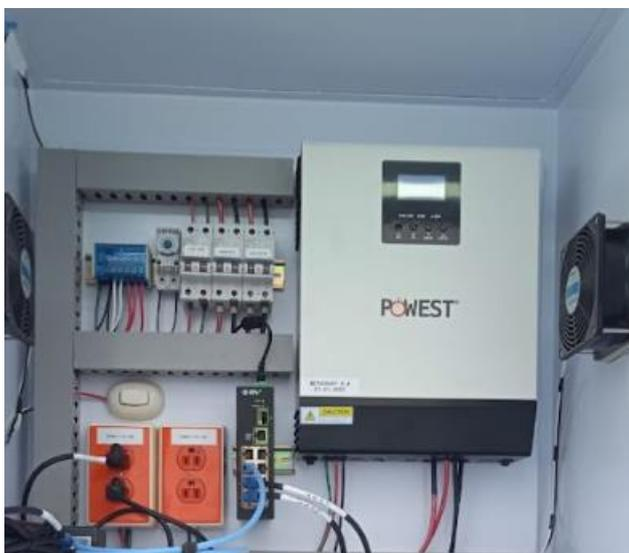
*Nota.* Fotografía capturada por el autor de un inversor y sus conexiones en funcionamiento para un sistema fotovoltaico.
