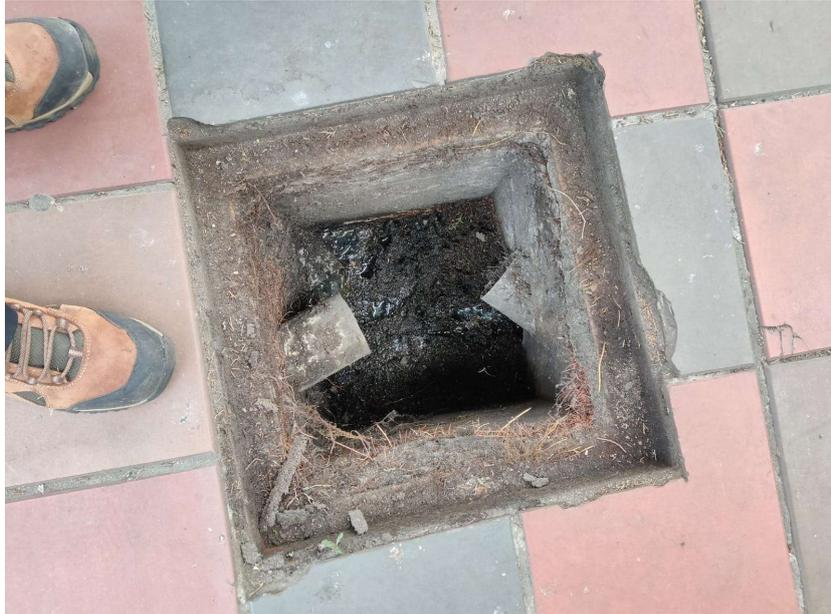
*Nota.* Fotografía donde se aprecia una acumulación de sedimentos en el fondo de una caja de revisión. Elaborado por: El autor.
