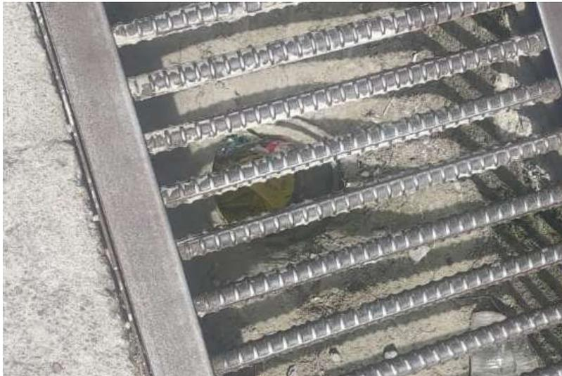
*Nota.* Fotografía de sumidero en el cual se visualiza una acumulación de basura en la tubería de desagüe. Elaborado por: El autor.
