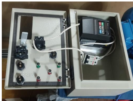
Figura 53. Implementación de la botonería y selector en el cajetín.
