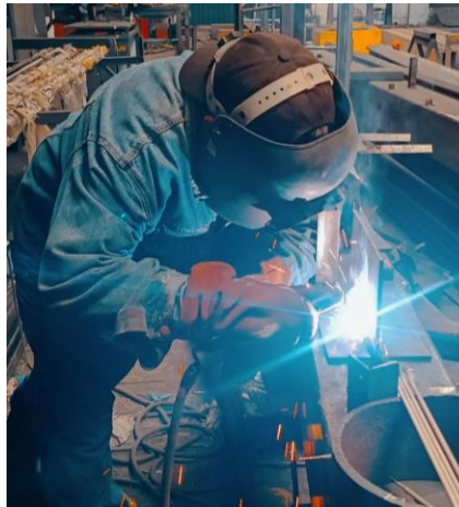
Figura 6. Posición de Soldadura 2F
