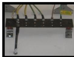
Figura 51: Barra metálica de conexión a tierra.
