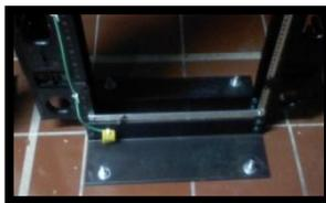
Figura 52: Barra vertical y horizontal de tierra
