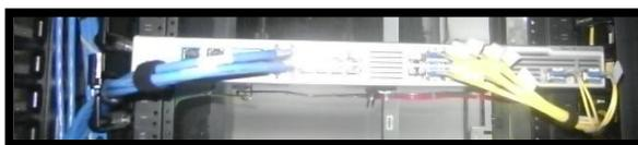
**Figura 224: ME-3800X instalado Vista Frontal.**
