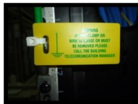
Figura 181: Etiqueta de la conexión a tierra del equipo ME-3800X.
