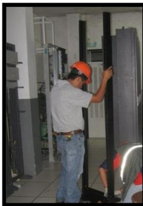
**Figura 189: Instalación del Rack.**
