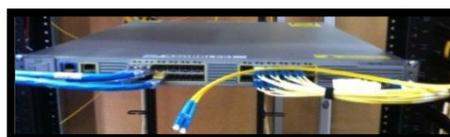
**Figura 100: ME-3800X instalado Vista Frontal.**
