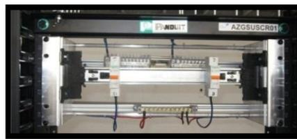
**Figura 172: Switches de -48VDC.**
