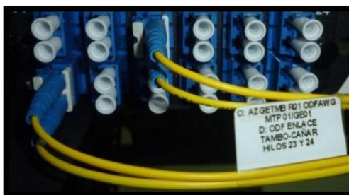
Figura 63: Estructura de Etiquetación de Cables.
