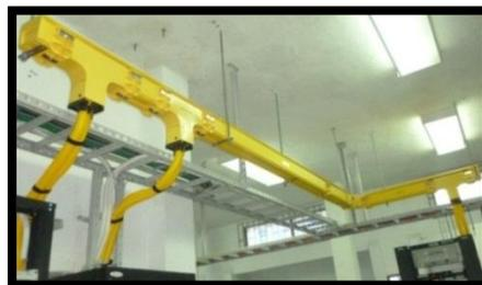
Figura 39: Sistema de Enrutamiento para fibra óptica.
