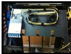
**Figura 98: ODFWG Instalado con Cassette MPO de 24 hilos**
