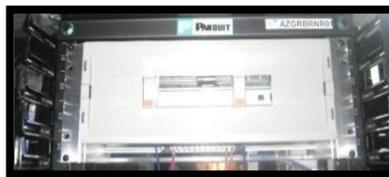
Figura 221: PDU Instalado.
