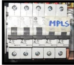
**Figura 71: Switches para Fase MPLS III marcados.**
