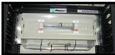
Figura 249: PDU Instalado.
