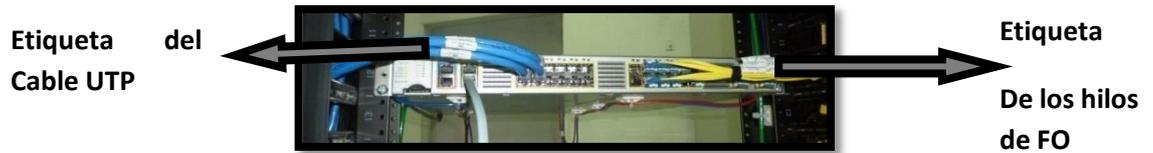
Figura 179: Etiquetado de los cables de cobre y fibra óptica.
