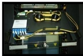
Figura 45: Sistema de Fibra Óptica
