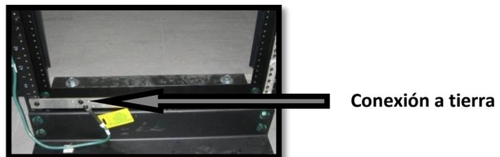
Figura 258: Sistema de conexión a tierra del Rack.
