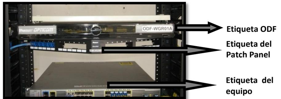
Figura 263: Etiquetado de los elementos del Rack
