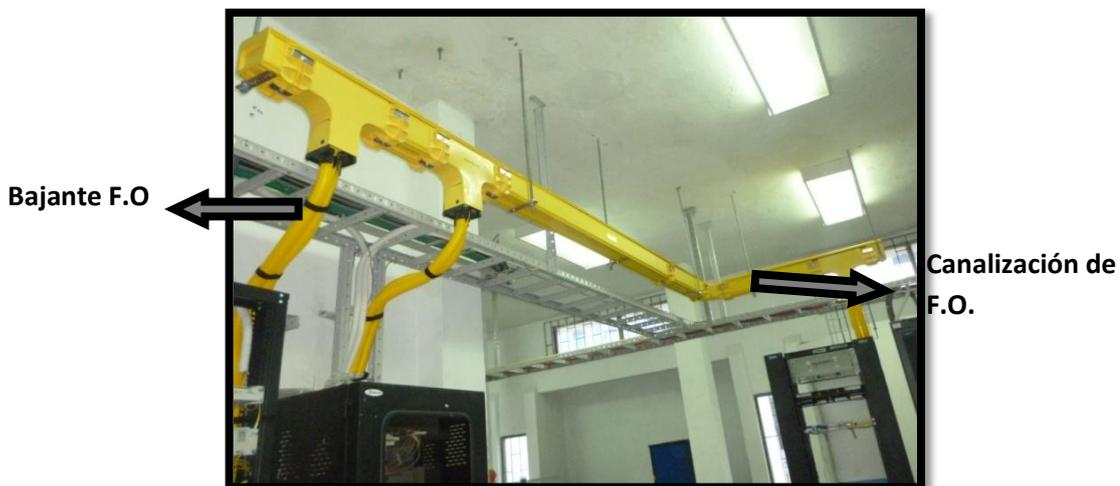
Figura 177: Canalización Fibra Óptica.
