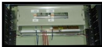
Figura 167: PDU Instalado.
