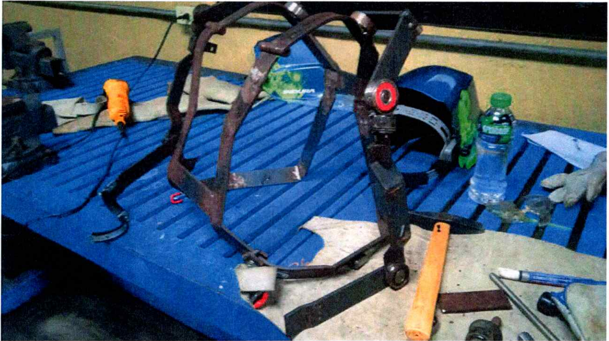
Figura 40: Estructura en proceso de ensamblaje
