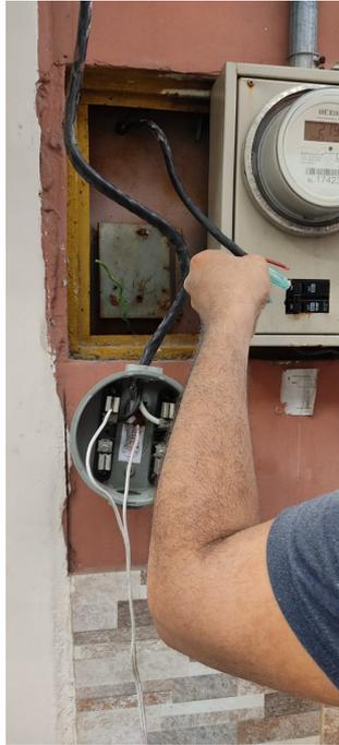
Figura 116. Acometida de Medidor parte a. Elaborado por autores.
