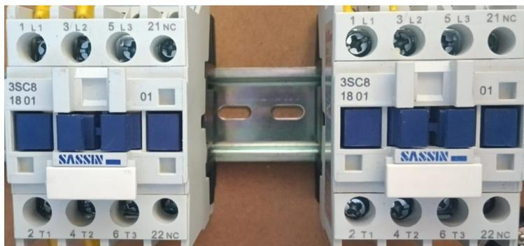
Figura 25. Contactores 18A. Elaborado por autores.
