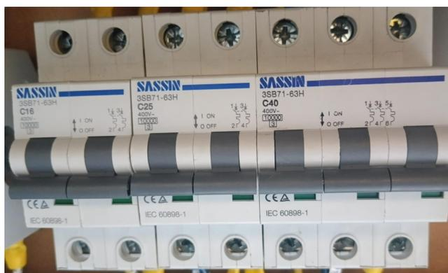
Figura 27. Breakers de alimentación 2P 16A / 2P 25A / 3P 40A. Elaborado por autores.
