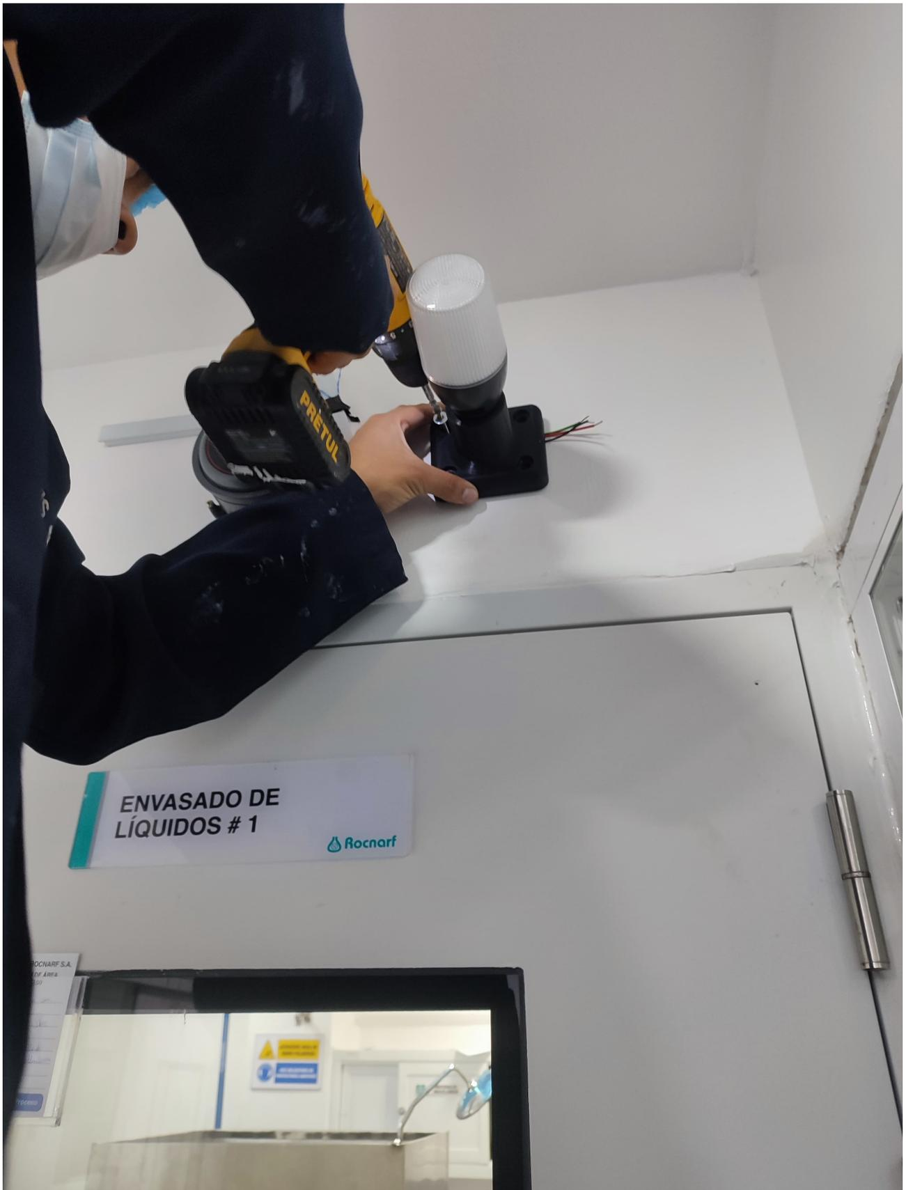
Figura 84. Ubicación de balizas junto a los sensores, por L. Ramírez y J. Castro.
