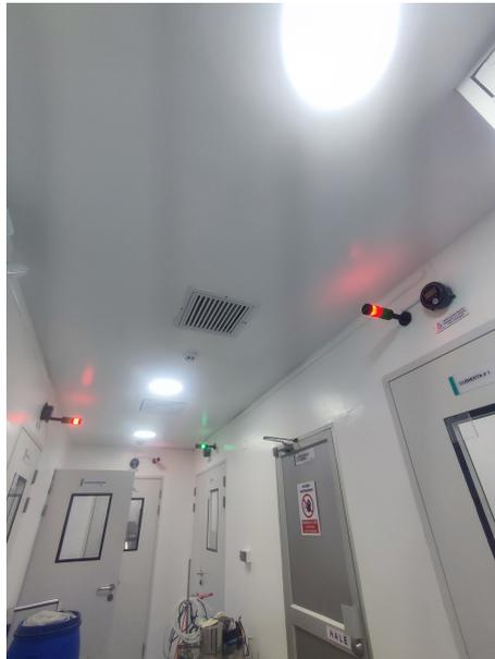
Figura 73. Funcionamiento de balizas junto a sensores dentro de la primera área.
