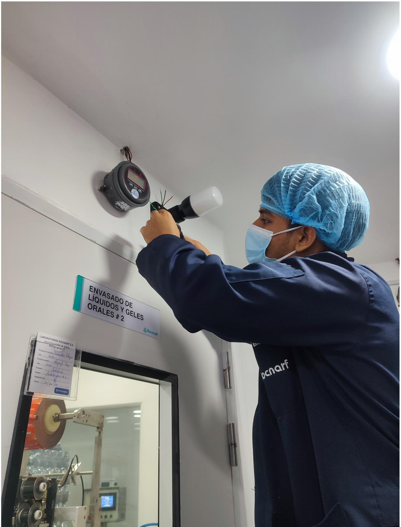
Figura 85. Conexión de balizas a los sensores y tablero de control, por L. Ramírez y J. Castro.
