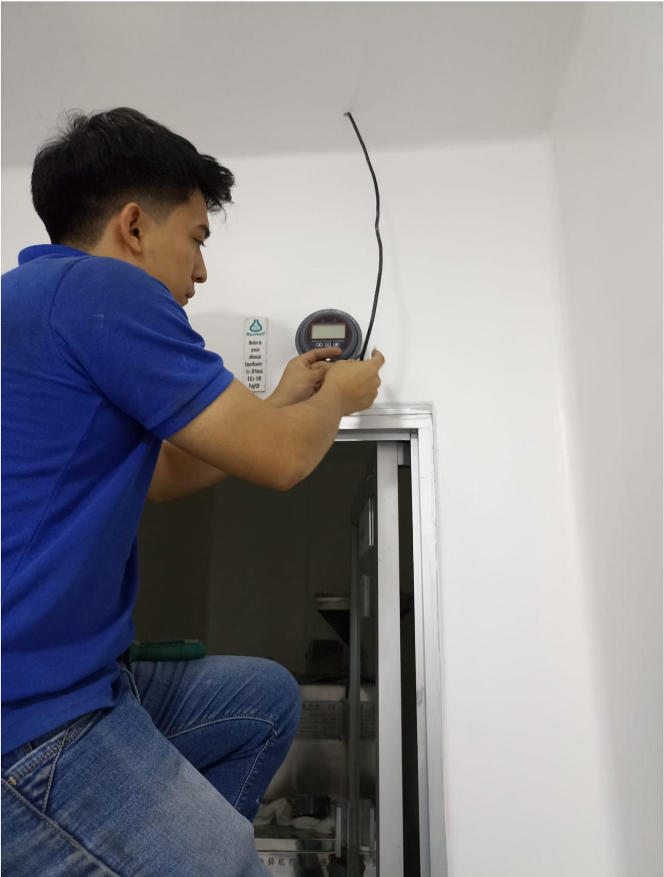
Figura 83. Instalación del sensor de presión diferencial, por L. Ramírez y J. Castro.
