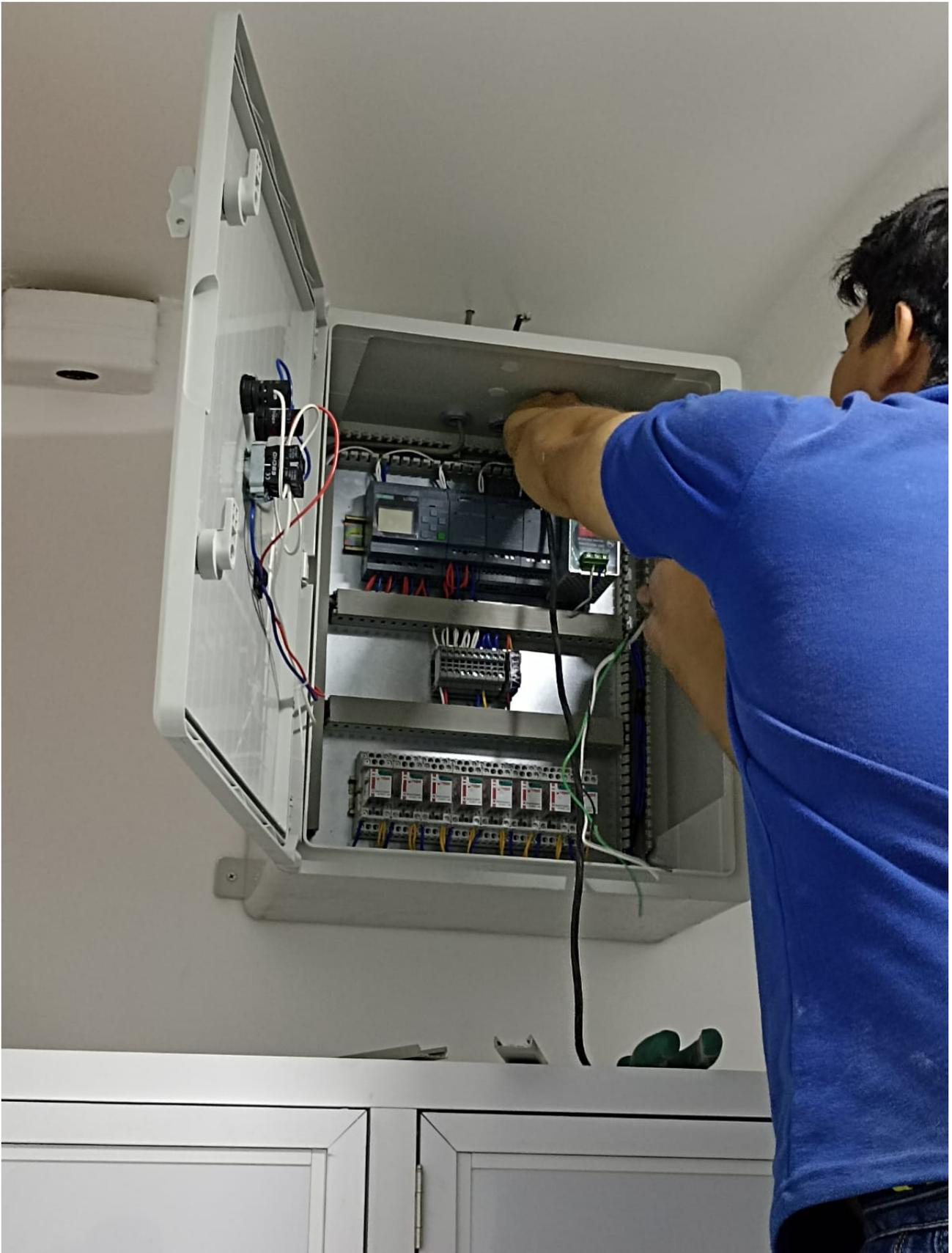
Figura 86. Conexión de balizas y sensores al tablero de control, por L. Ramírez y J. Castro.
