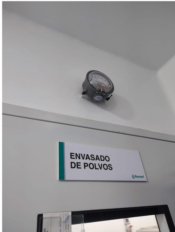
Figura 19. Sensor analógico mecánico, por L. Ramírez y J. Castro.
