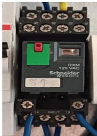
Nota. Relé Schneider 120 vac (Schneider Electric, 2024).
