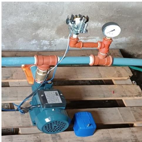
Nota. Presión contante por medio del presostato que censa la presión del agua al estar baja.
