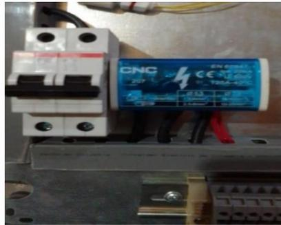
Nota. Breaker de 2 polos (Bricoeilige, 2024) y Distribuidor de Carga (Ingelcom, 2024).
