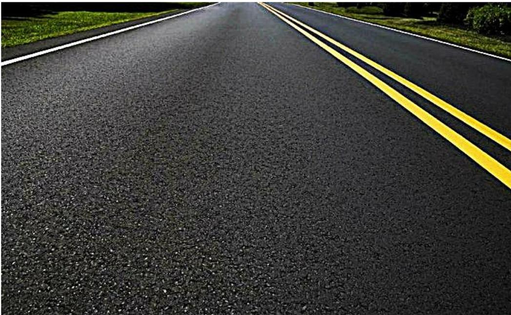
*Nota.* Capa asfáltica pavimento flexible. Tomado de: (Suárez, 2019)
