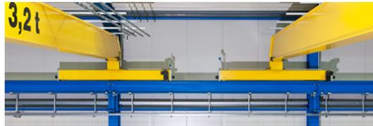
Figura 12: Vigas testeras [26].
