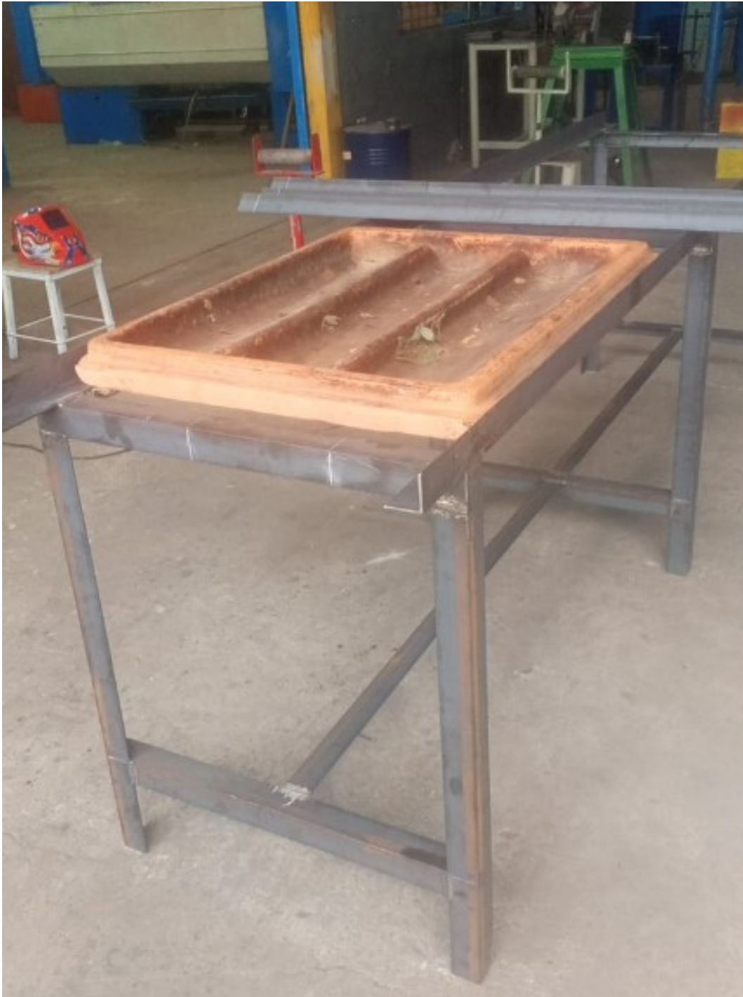
Figura 49. fabricación de estructura
