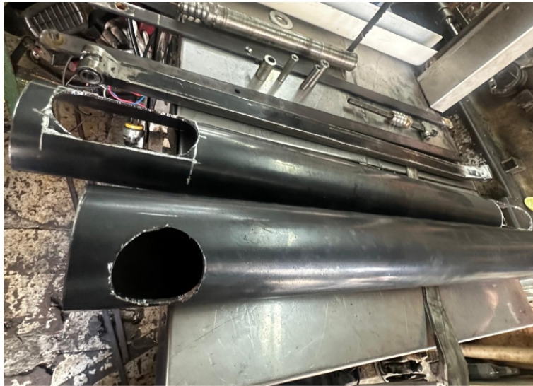
Figura 97. Construcción del brazo mecánico. Fuente: Autor
