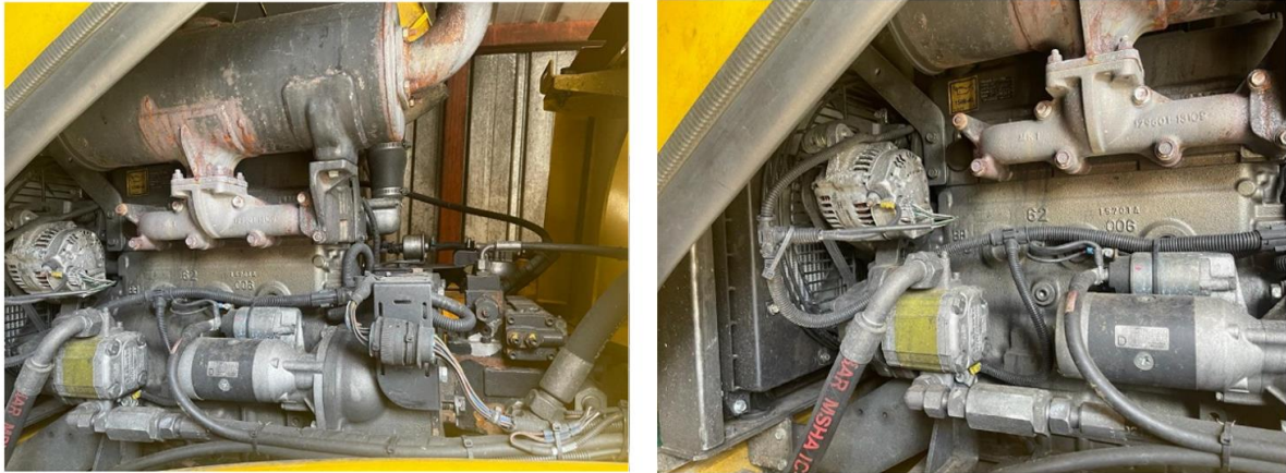
Figura 49. Vista del Motor de la Volteadora
