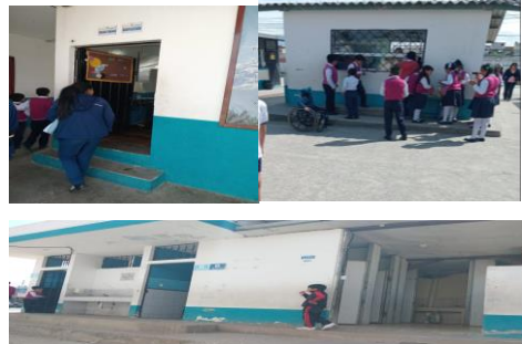
Fotografía N.ª 6 Inspección, bar y baños
