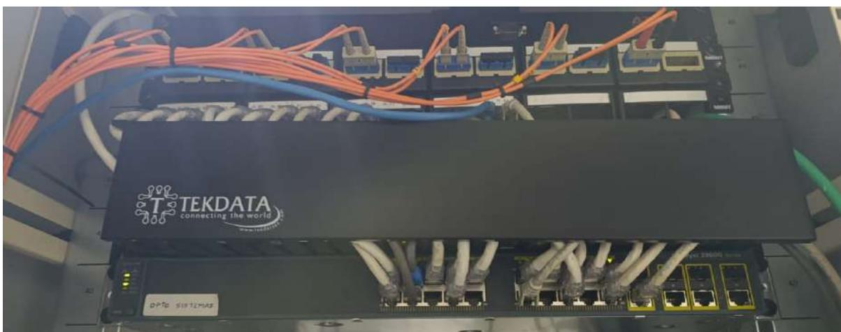
Figura 4.21: Conexión de enlaces de Fibra Óptica.
