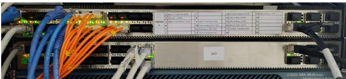
Figura 4.20: Instalación de Switch de Core.
