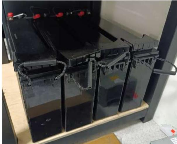
Figura 4.39: Instalación de banco de baterías de 48V.
