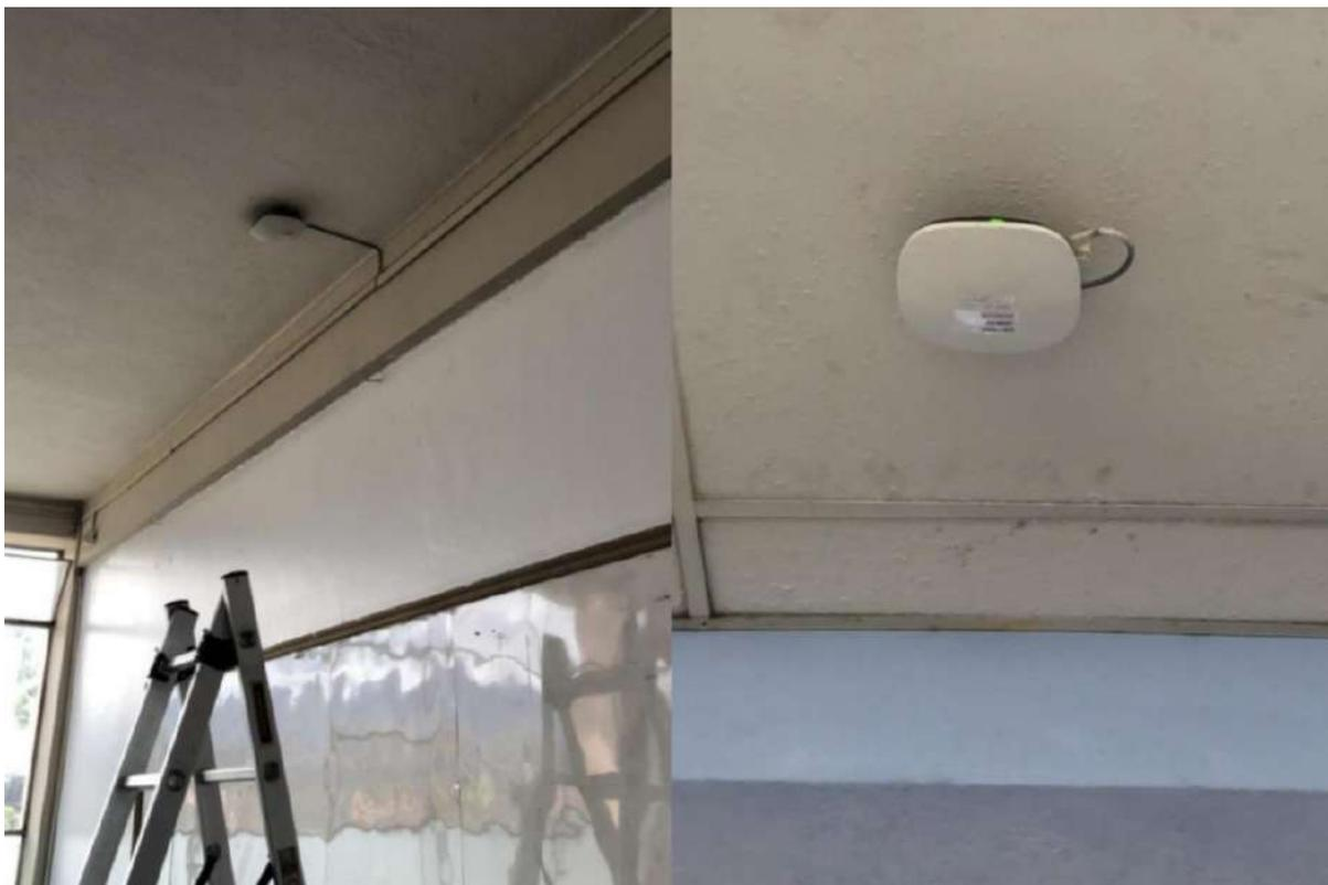
Figura 4.36: Instalación de AP.
