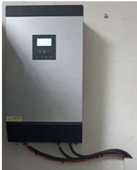
Figura 4.40: Instalación de Equipo MPS 5kva.
