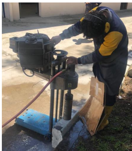
Figura 25. Extracción de núcleos
