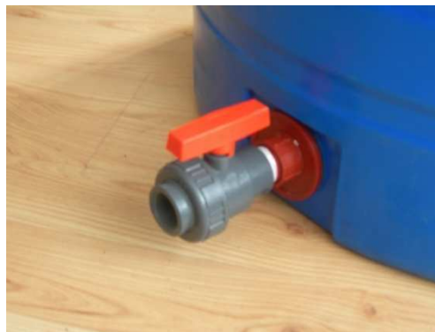
Figura 24: Válvula de salida de lodos
