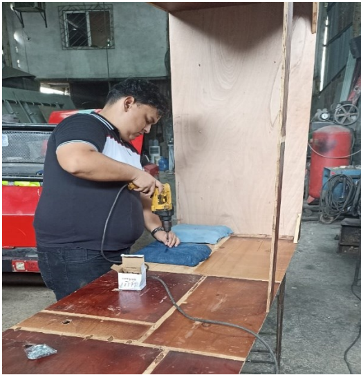
Ilustración 33 Implementación de los paneles fonoabsorbentes en la caja acústica
