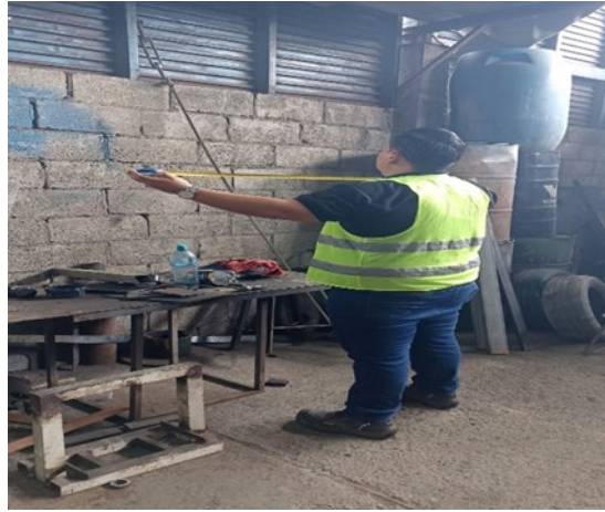
Ilustración 28 Determinación en donde serán ubicados los paneles fonoabsorbentes
