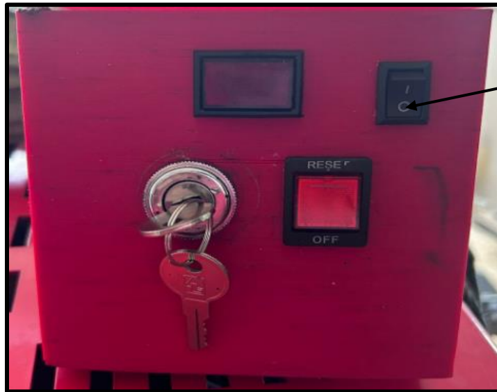
Figura 2.9 Instalación del Swich para el ventilador
