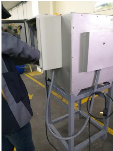
Fig.35. Empotramiento del tablero eléctrico.
