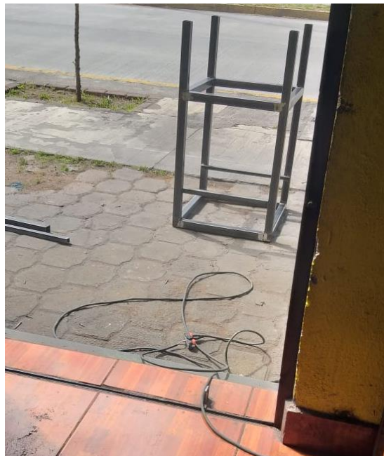
Fig.26. Estructura finalizada con una capa de fondo anticorrosivo.
