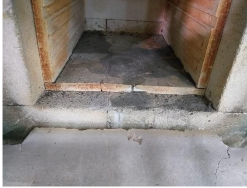
Fig.16. Estado actual de la cámara del horno.
