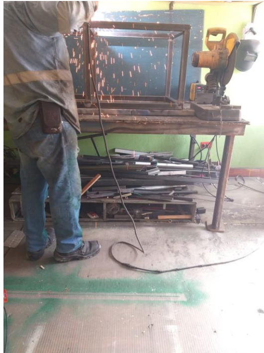
Fig.25. Elaboración de los cordones de soldadura.
