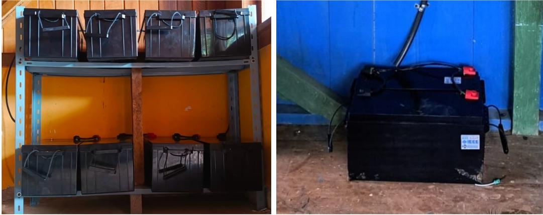
**Figura 3.8:** Bancos de baterías para los sistemas fotovoltaicos.
