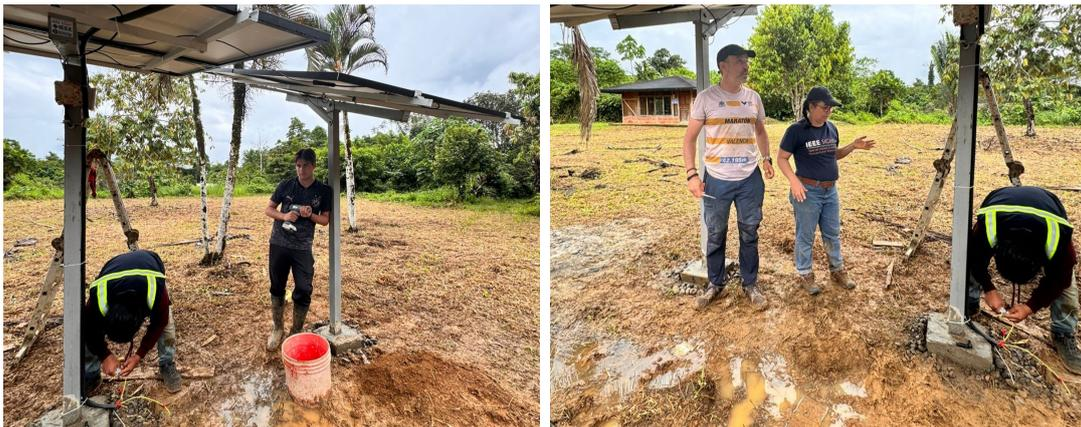
**Figura 3.13:** Conexión de toma a tierra.
