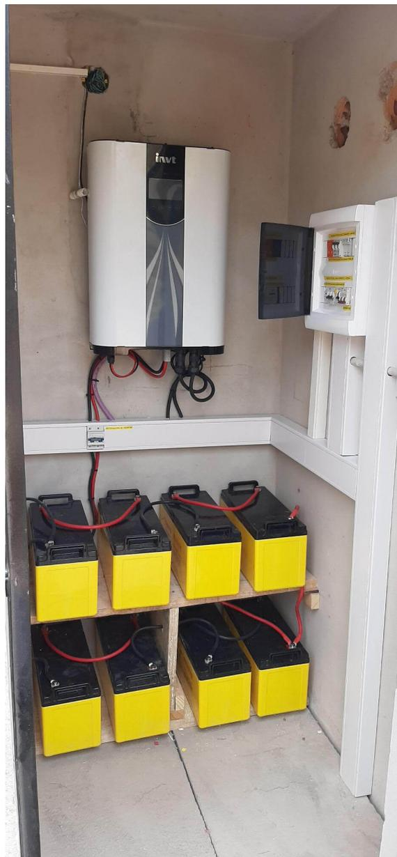
**Figura 4.10:** Baterías en el cuarto de almacenamiento
