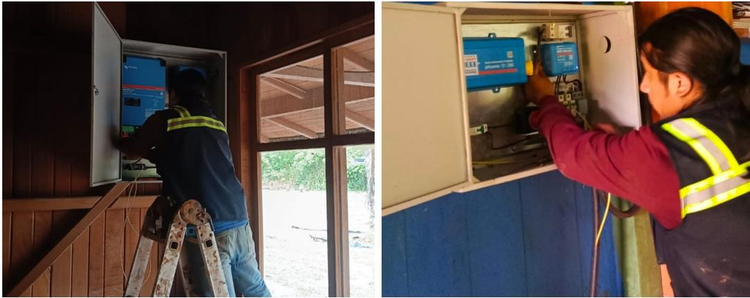
**Figura 3.14:** Conexión de los equipos y protecciones.
