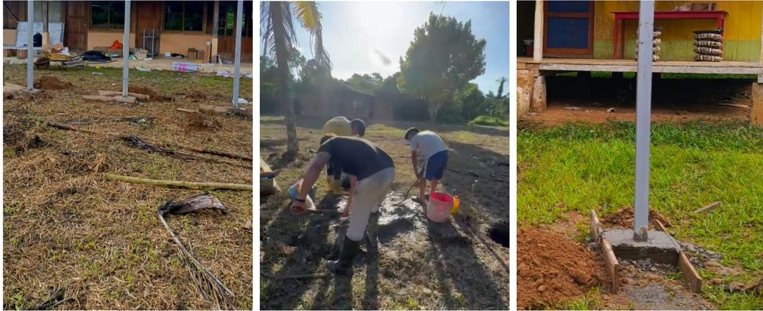
**Figura 3.4:** Hormigonado de las bases para las estructuras.
