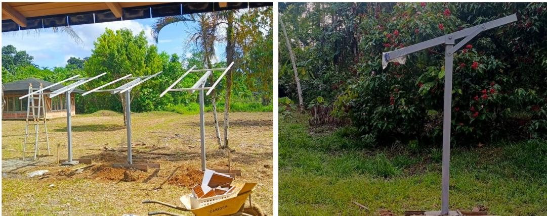
**Figura 3.5:** Soportes para los módulos fotovoltaicos.
