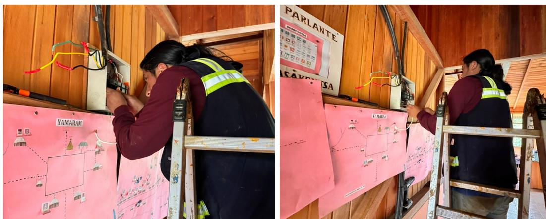
**Figura 3.17:** Conexión la nueva acometida al tablero de distribución.
