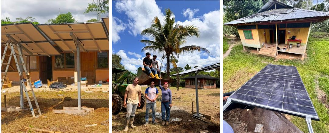
**Figura 3.6:** Módulos solares sobre la estructura.
