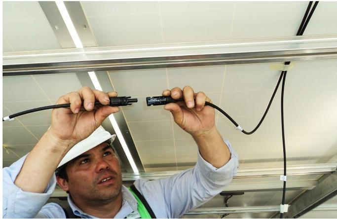
**Figura 4.9:** Revisión de las conexiones en los paneles solares por el técnico
