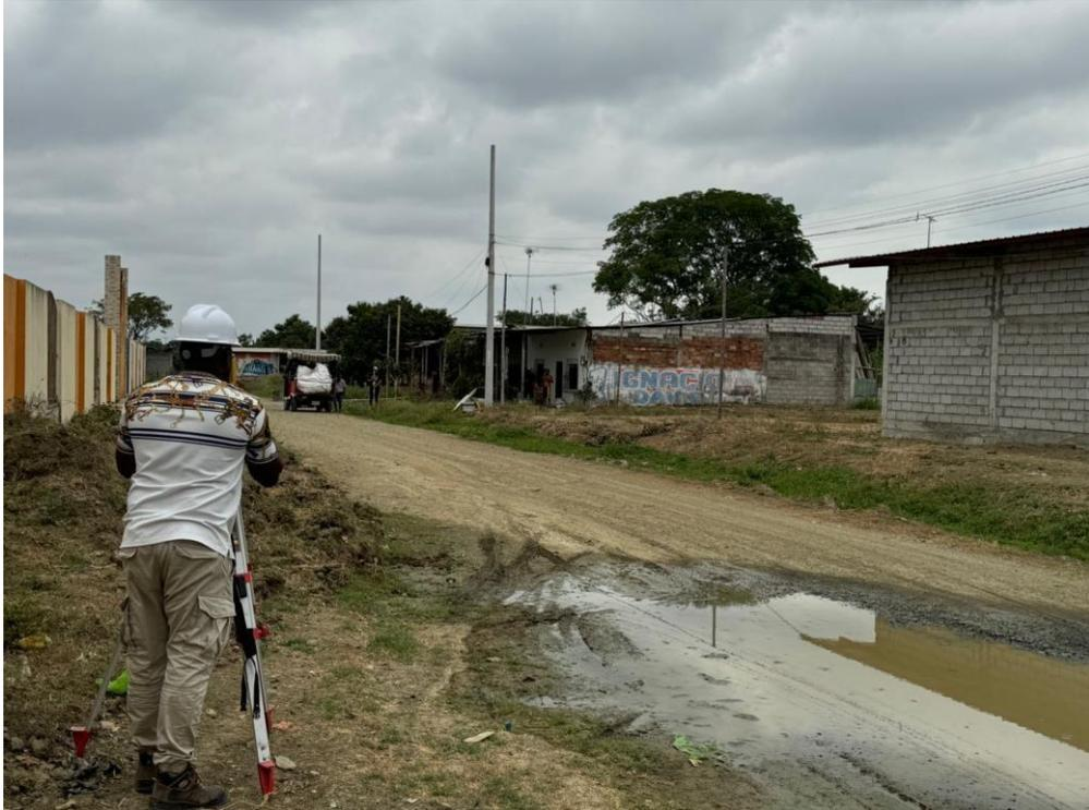
**Imagen 30 Medición del Terreno con Estación Total**
