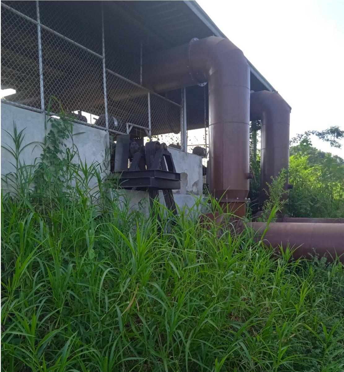
*Ilustración 36 Tuberías de succión de la estación de bombeo Pula-Junquillal*
