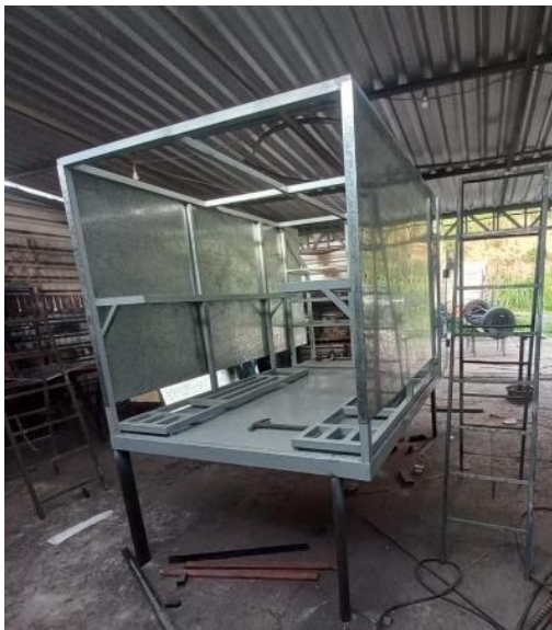
Figura 50.- Inicio de recubrimiento lateral
