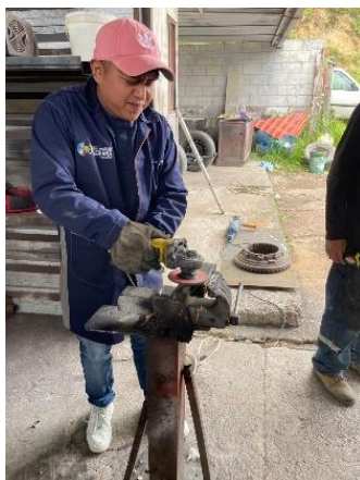
Figura 70.- Pulido del cordón de la soldadura
