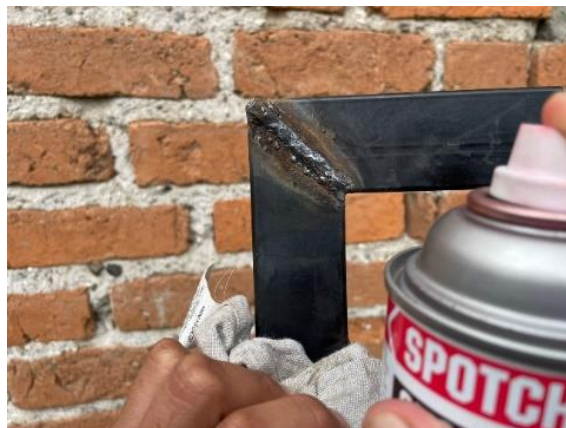
Figura 60. - Limpieza de zona a inspección
