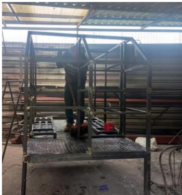
Figura 48.- Estructura montada sobre el piso del remolque
