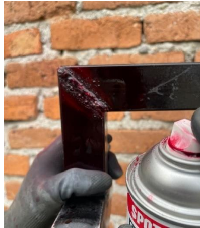
Figura 61.- Aplicación de líquido penetrante
