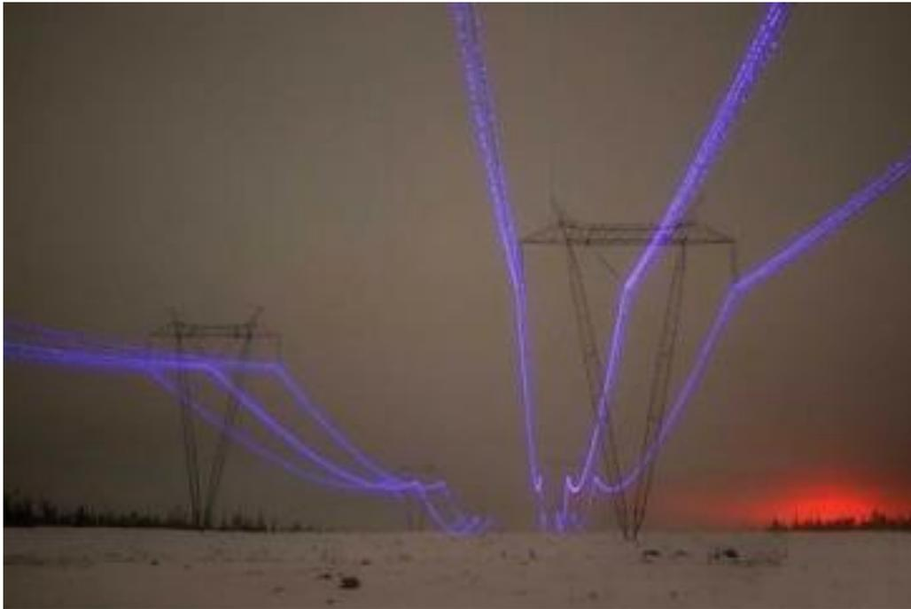
**FIGURA 5.** Efecto corona a simple vista en líneas de transmisión causado por la ionización del aire
