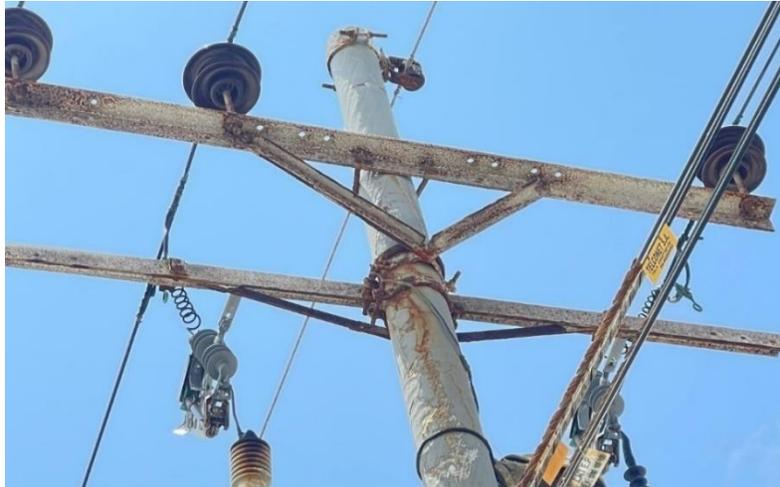
**FIGURA 53.** Evaluación de los aisladores instalados en el poste 16021488
