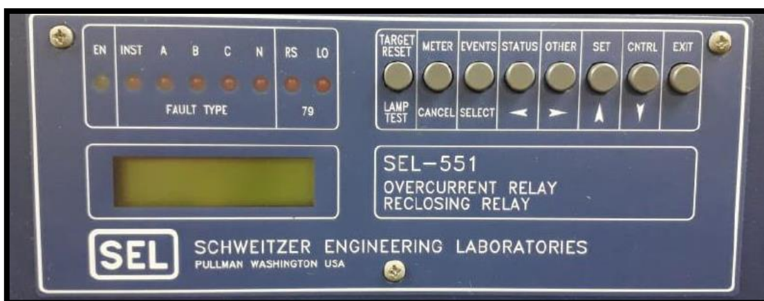
Figura 8. Relé SEL-551 de la UPS, GYE, Campus Centenario.
