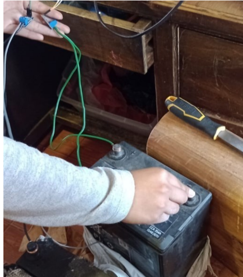
Figura 69. Pruebas de monitoreo en baterías de carro.
