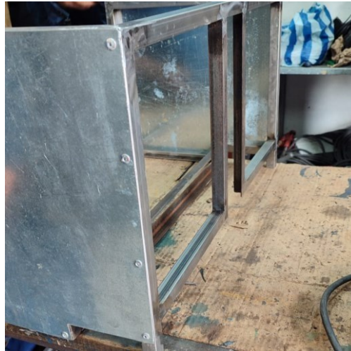
Figura 61. Construcción del banco de monitoreo de voltaje.
