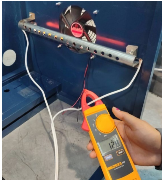
Figura 50. Medición de corriente en las resistencias térmicas del banco de monitoreo.
