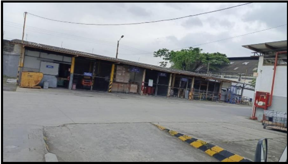
Anexo 3. Parte exterior de los cuartos de los desechos peligrosos.
