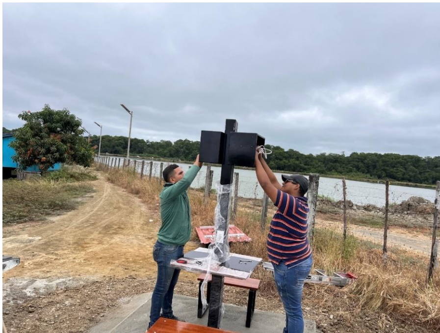
Figura 38. Colocación de equipos
