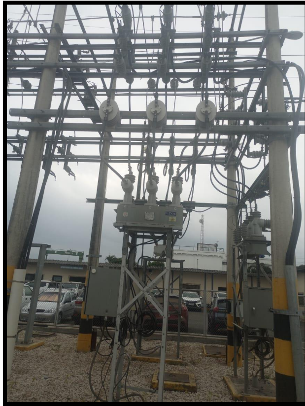
Figura 17. Reconectador del alimentador Primavera 2.
