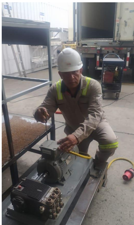
Imagen 17 Mantenimiento de bomba tipo matrimonio.
