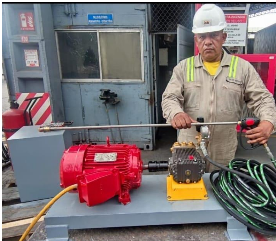
Imagen 16 Autor instalando bomba tipo matrimonio.
